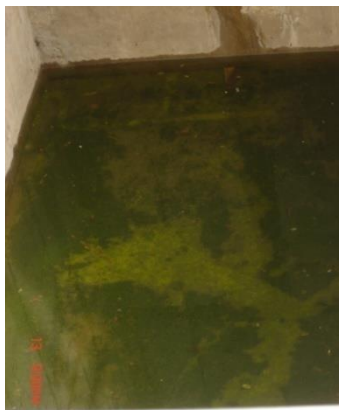
Figura 20. Digestor de Lodos. PTAR-UNA 6 .
