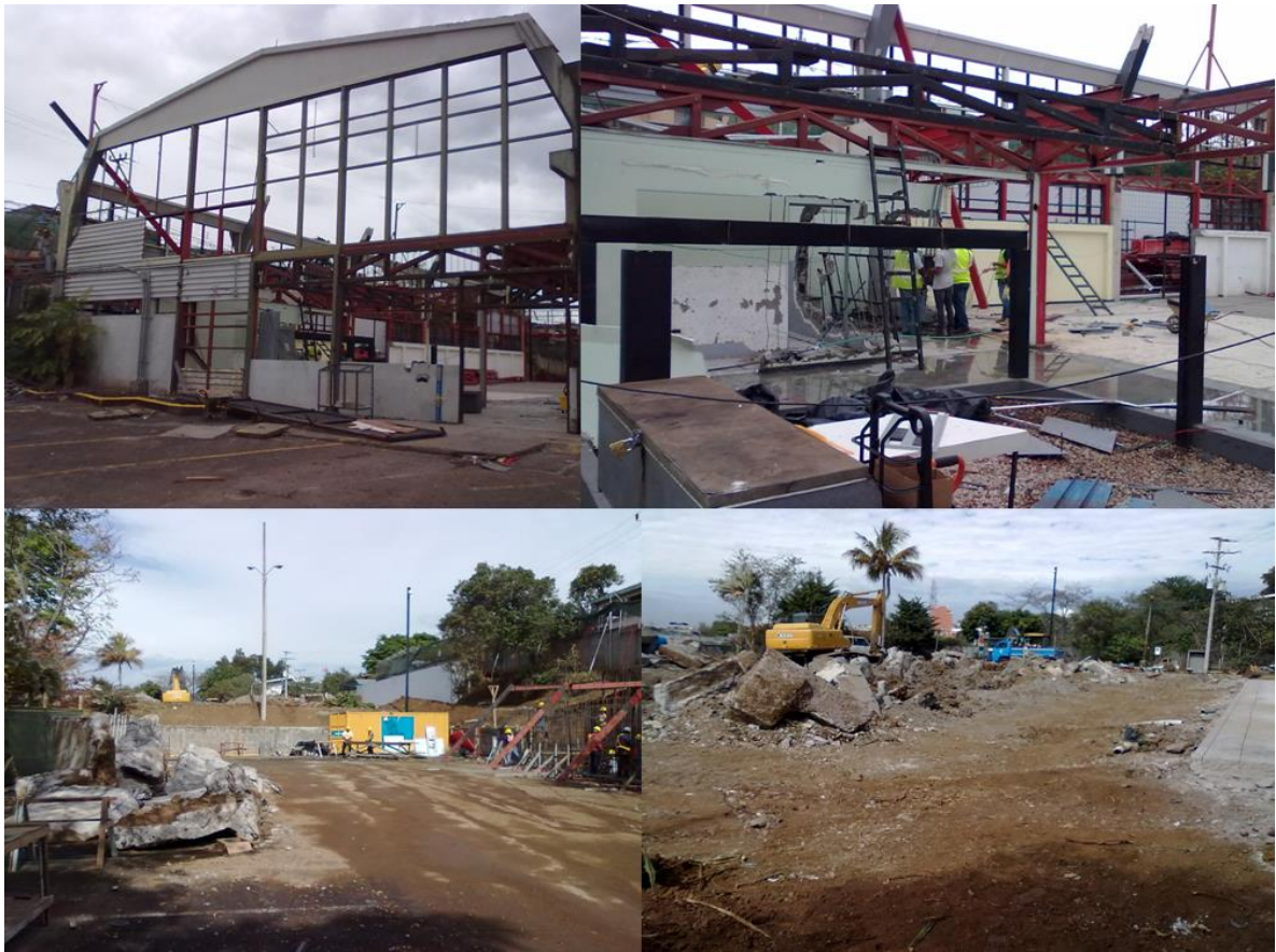
Figura 27. Proceso general de la demolición.
