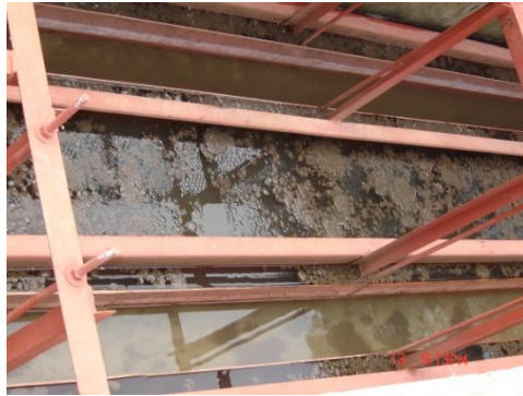
Figura 19. Sedimentadores. PTAR-UNA 6 .
