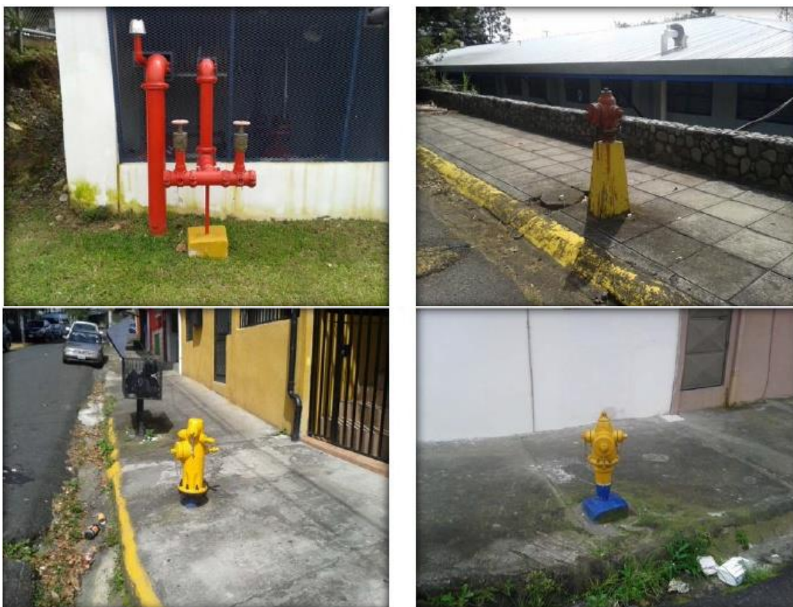
Figura 42. Fotografías de dispositivos para la atención de incendios existentes en varios puntos del Campus Omar Dengo. Fuente: Geocad, 2015.
