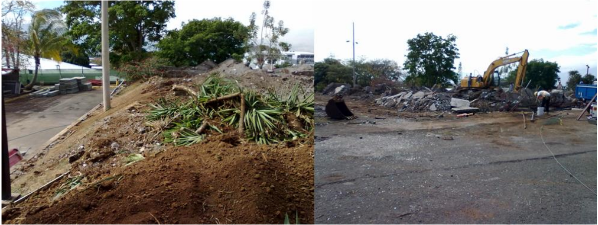
Figura 25. Material de relleno (tierra y escombros) dispuestos en propiedad privada.
