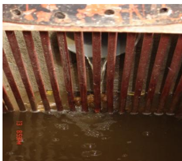
Figura 16. Sistema de rejillas-PTAR-UNA 6
