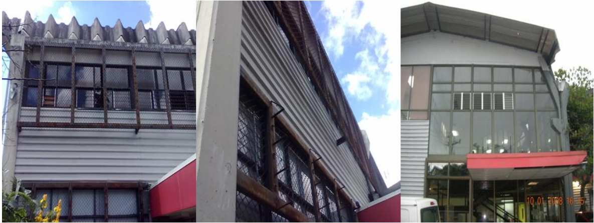
Figura 22. Instalaciones previo proceso de demolición.
