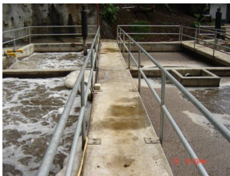
Figura 18. Tanques de aireación. PTAR-UNA 6 .
