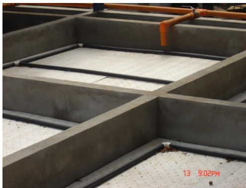
Figura 21. Lechos de Secado. PTAR-UNA 6 .
