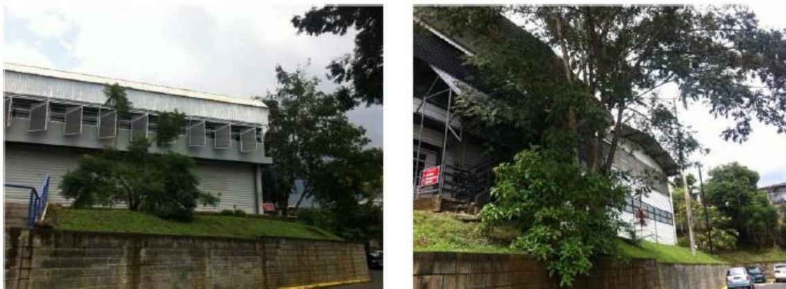
Figura 2. Imágenes del área del proyecto y sus pendientes. Fuente: Geocad, 2015.
