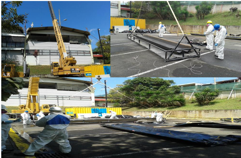
Figura 26. Tratamiento y disposición de asbesto.
