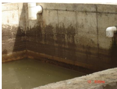
Figura 17. Tanque de homogenización. PTAR-UNA.
