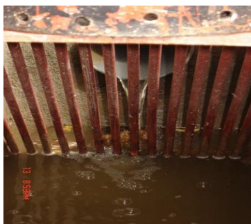
Figura 14. Sistema de rejillas-PTAR-UNA 6
