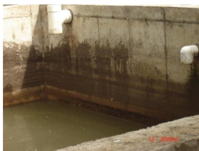
Figura 15. Tanque de homogenización. PTAR-UNA.
