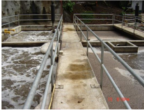
Figura 16. Tanques de aireación. PTAR-UNA 6 .
