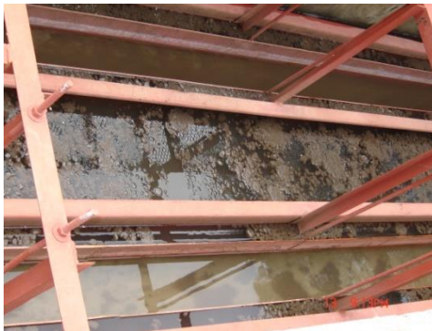
Figura 17. Sedimentadores. PTAR-UNA 6 .
