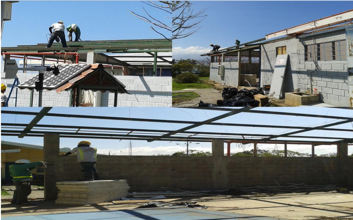
Figura 22. Proceso general de la demolición.
