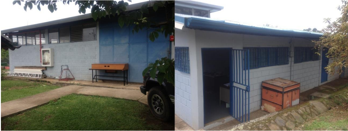
Figura 20. Instalaciones previo proceso de demolición.
