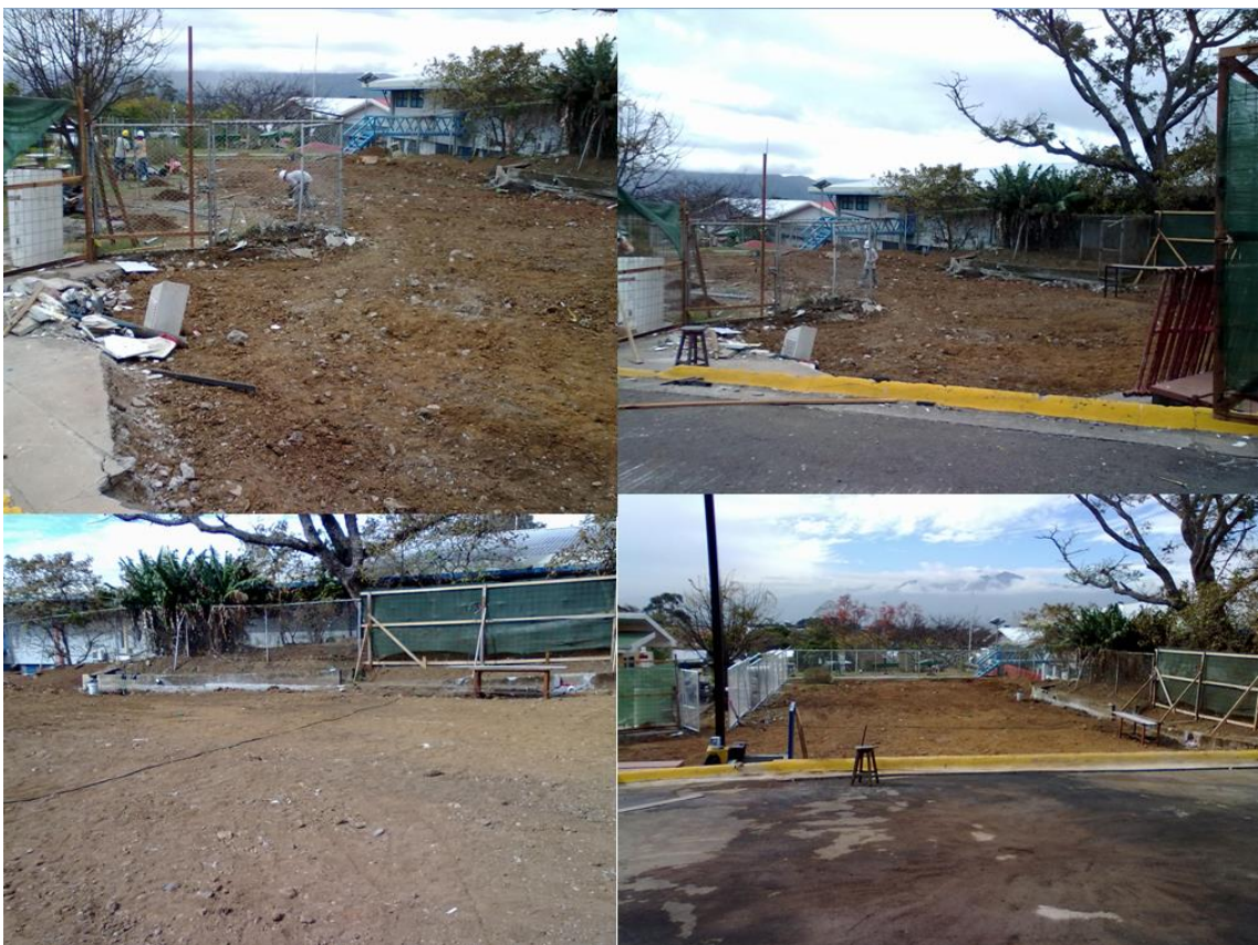
Figura 23. Etapa final de la demolición.
