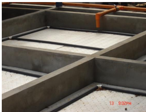
Figura 19. Lechos de Secado. PTAR-UNA 6 .
