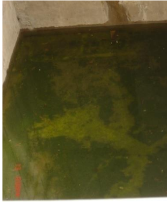
Figura 18. Digestor de Lodos. PTAR-UNA 6 .
