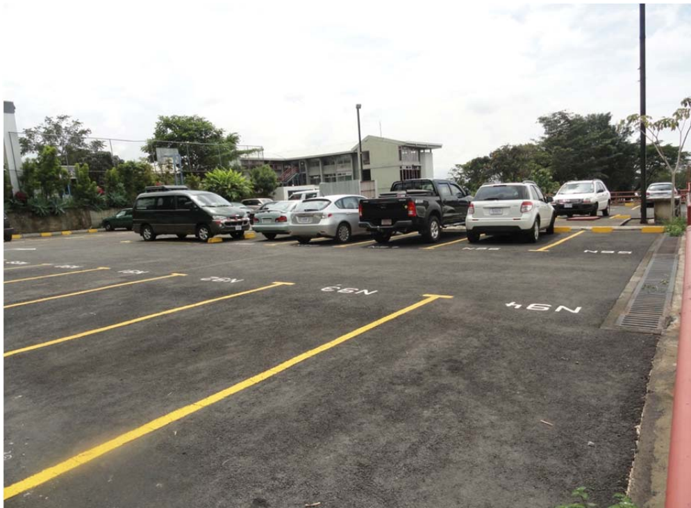
Fotografía 2.1. Vista del sitio en donde se construirá el edificio de Procesos Artísticos
