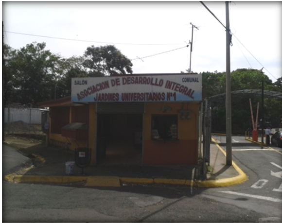
Fotografía N° 5.13. Salón comunal de "Jardines Universitarios 1", contiguo a una de las entradas vehiculares al "Campus" (MAPG-Noviembre, 2013)
