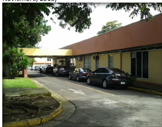
Fotografía N° 4. Instalaciones del SENASA en las cercanías del AP, dentro de "Campus Benjamín Núñez" (MAPG-Noviembre, 2013)
