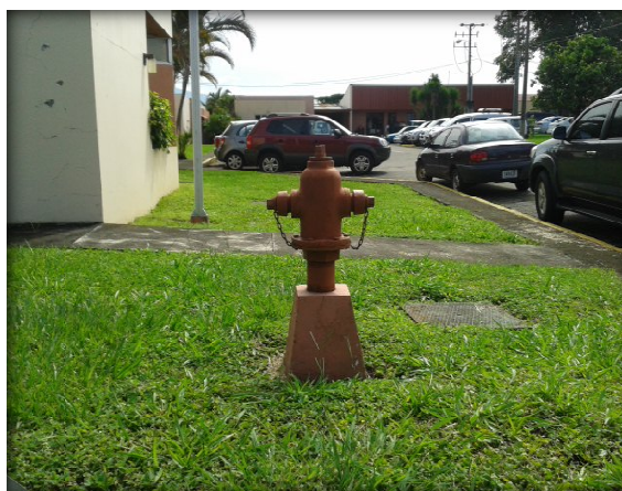
Fotografía 5. Ejemplo del tipo de servicio de emergencia identificado en los sitios aledaños al AP. Se trata de un hidrante en las instalaciones del SENASA, frente al costado Este del AP (MAPG- Noviembre, 2013).
