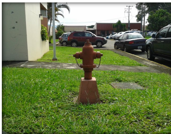
Fotografiografía 11. Ejemplo del tipo de servicio de emergencia identificado en los sitios aledaños al AP. Se trata de un hidrante en las instalaciones del SENASA, frente al costado Este del AP (MAPG- Noviembre, 2013).
