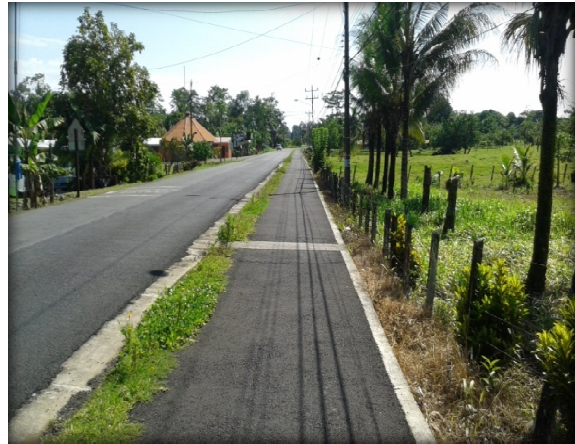
Fotografía 5.12. Tramo de la acera y ciclovía en las afueras del “Recinto Sarapiquí” (MAPG-Noviembre, 2013)
