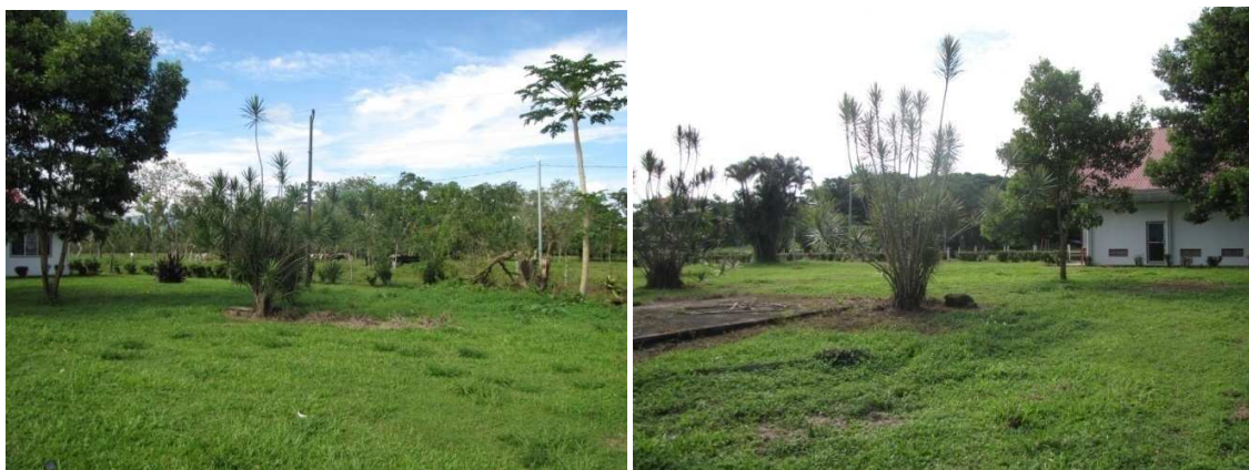
Fotografías 8.3 y 8.4. Área de proyecto. Edificio de residencias. Campus de la Universidad Nacional – Sede Sarapiquí. Sarapiquí, Heredia. Fotografía tomada en el mes de octubre de 2013.
