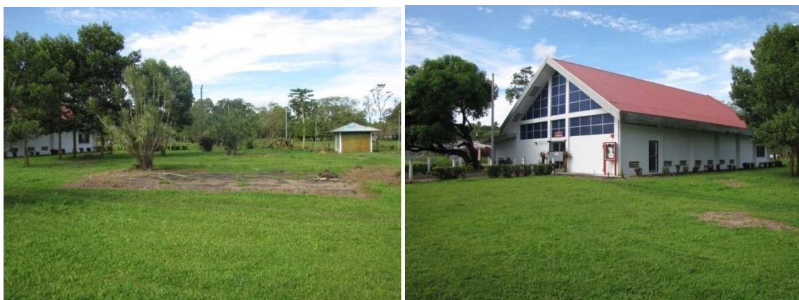
Fotografías 4.5 y 4.6. Área de proyecto. Edificio de residencias. Campus de la Universidad Nacional – Sede Sarapiquí. Sarapiquí, Heredia. Fotografía tomada en el mes de octubre de 2013.
