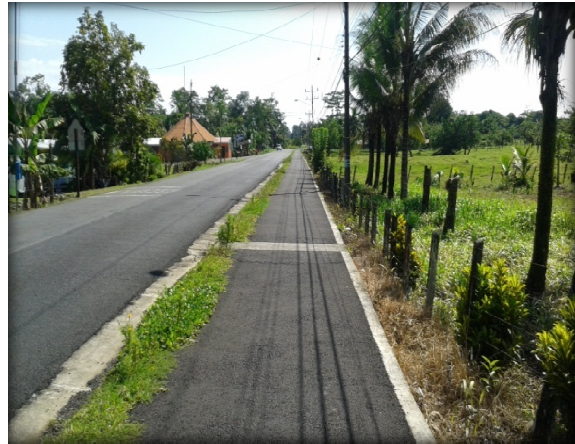
Fotografía 9.16. Tramo de la acera y ciclovía en las afueras del “Recinto Sarapiquí” (MAPG-Noviembre, 2013)
