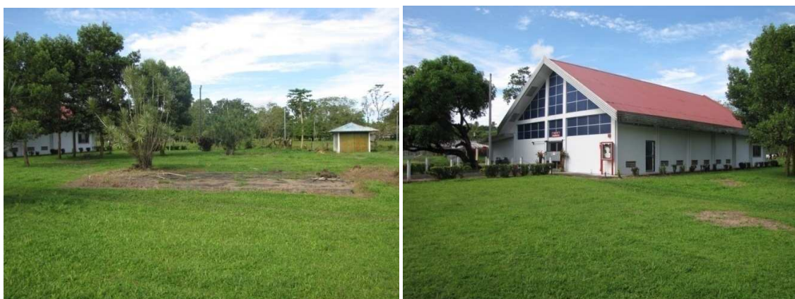
Fotografías 8.5 y 8.6. Área de proyecto. Edificio de residencias. Campus de la Universidad Nacional – Sede Sarapiquí. Sarapiquí, Heredia. Fotografía tomada en el mes de octubre de 2013.
