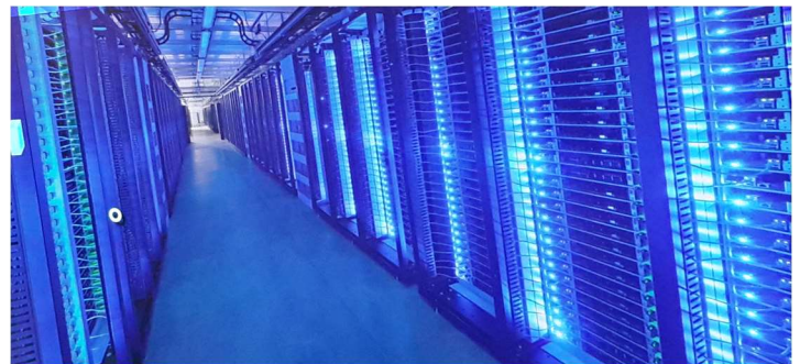
Datacenter de Facebook, Oregon, USA
