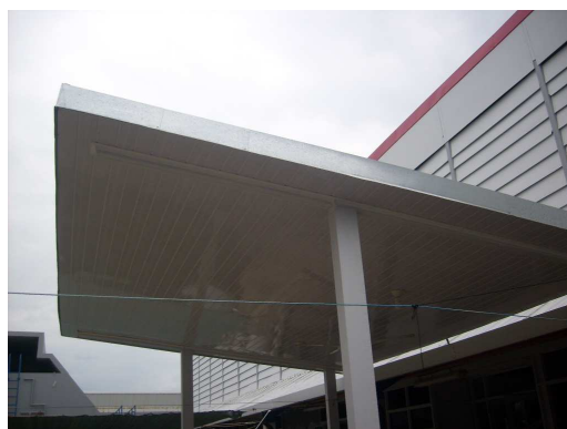
Fotografía 4. Remodelación del comedor de la Estación de Biología Marina
