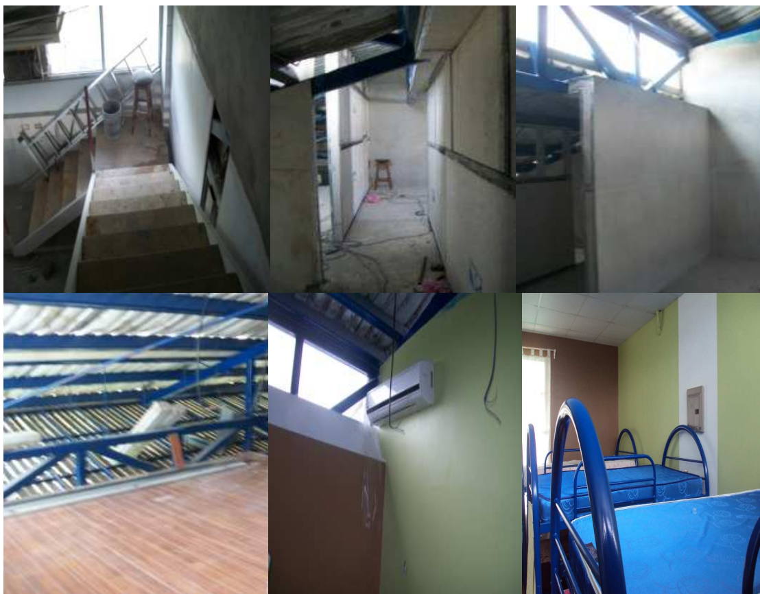
Fotografía 3. Construcción de habitaciones para estudiantes de la Estación de Biología Marina
