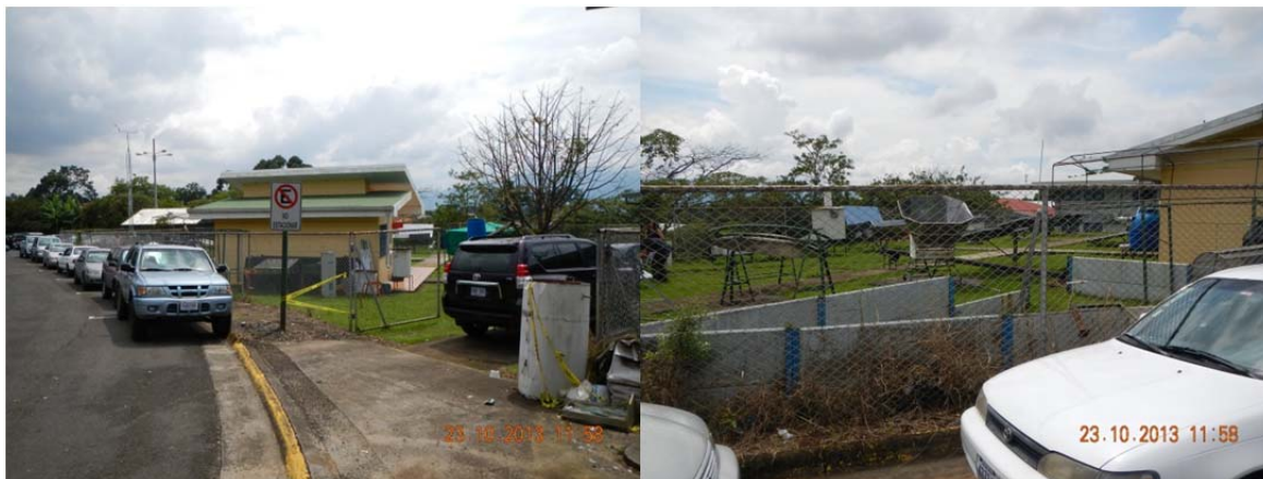
Fotografía 2.1. Vista del AP para Edificio de Física Médica Aplicada.
