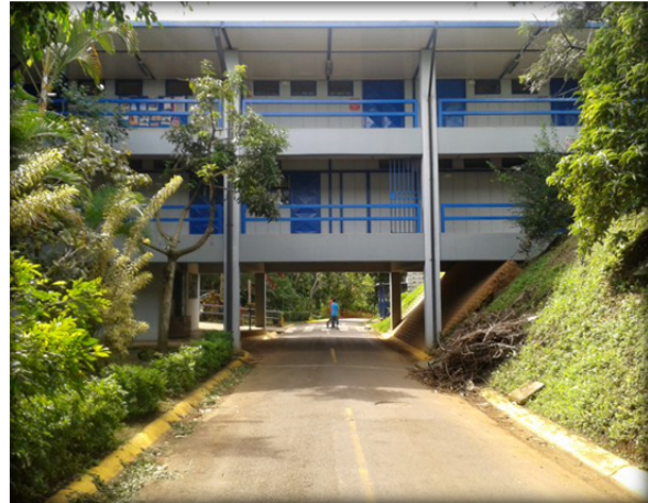
Fotografía N° 9.6. Calle interna en el “Campus Omar Dengo” que dispone de un paso elevado para peatones pero no aceras (MAPG-Noviembre, 2013)
