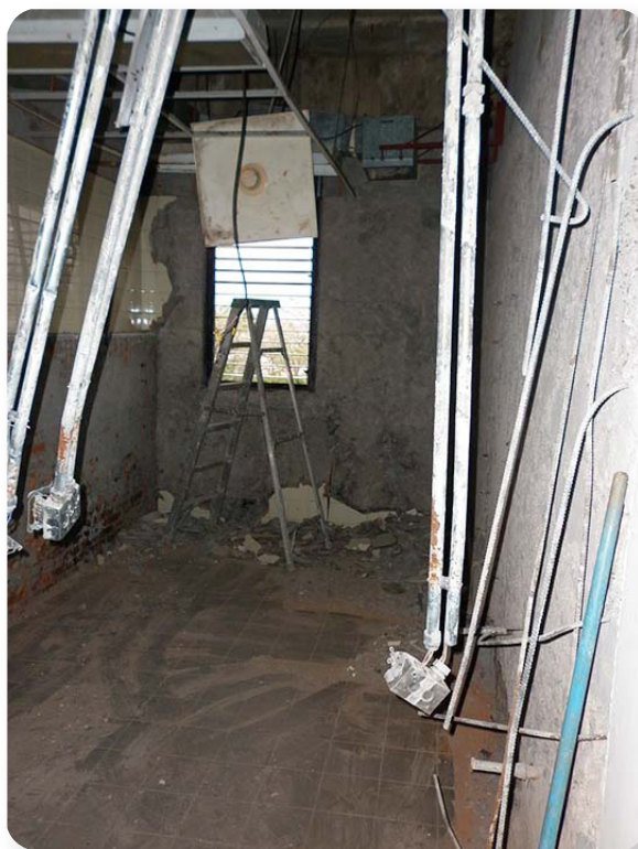
Figura 5. Proceso de remodelación en los sanitarios del edificio de Administración Universitaria, UTN.
