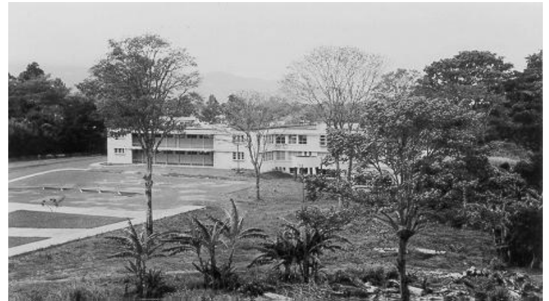
Edificio de la Facultad de Ingeniería.
