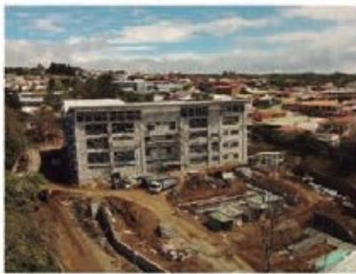
Edificio para la Innovación de los Aprendizajes y las Artes al fondo (vista oeste) y área de futuro parqueo al frente
