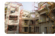
Residencias y Obras Recreativas Campus Pérez Zeledón
