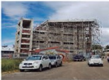
Edificio Radiaciones Ionizantes y No Ionizantes
