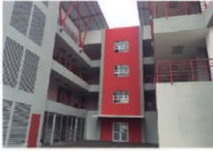
Edificio Emprendimiento, Educación Permanente y Cadena de Abastecimiento y Logística (CAI)
