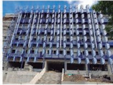
Edificio de nuevos procesos industriales y salud ocupacional y ambiental
