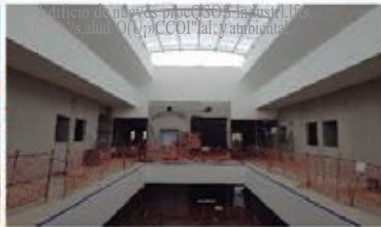
Edificio de nuevos procesos industriales y salud ocupacional y ambiental
